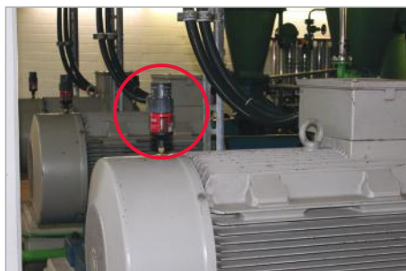
Lubrificazione di un motore elettrico
