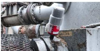
Lubrification des paliers d'un dispositif de ventilation
