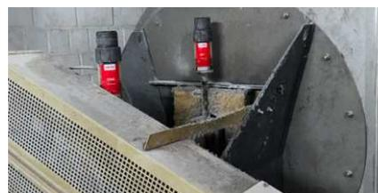
Lubrification du palier d'une soufflerie
