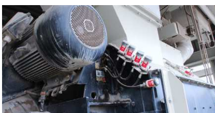
Lubrification des trappes et des arbres de mélangeur
