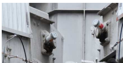
Lubrification des paliers à roulement des convoyeurs
