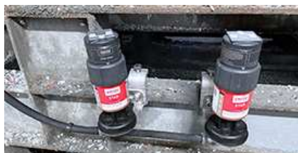
Lubrificazione di un motore elettrico sull'essiccatore
