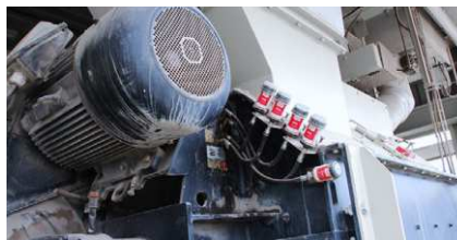
Mischerklappen- und Mischerwellenschmierung
