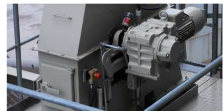
Schmierung von Wälzlagern am Füllerelevator
