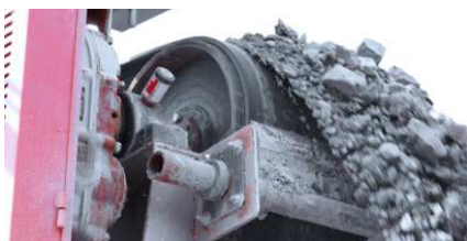
Lubrification du palier d'un convoyeur à bandes
