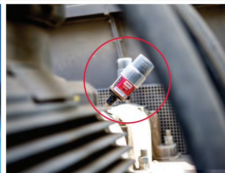
Lubrification de palier d'un dispositif de ventilation
