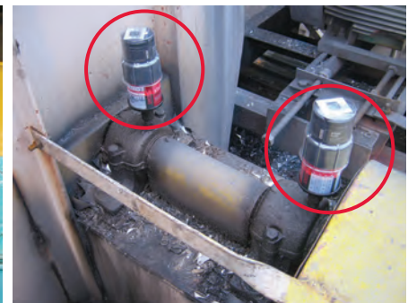
Lubrification d'un assemblage d'arbre de ventilateur
