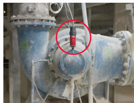
Lubrification du palier d'une pompe
