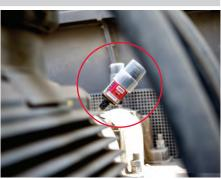
Bearing lubrication on a fan
