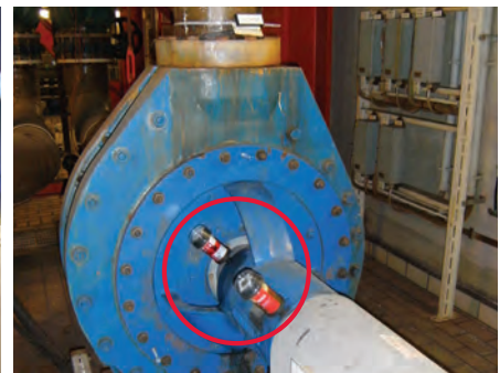
Lubrificação do eixo motriz de uma bomba
