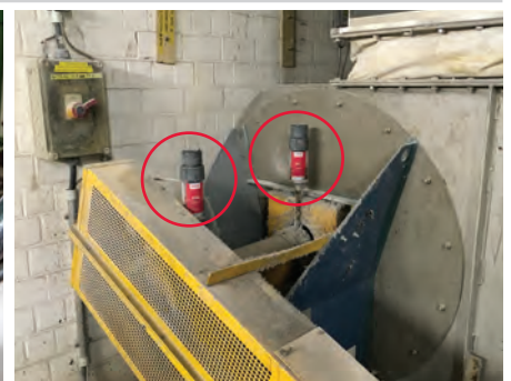
Lubrificação dos rolamentos de exaustores e ventiladores
