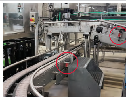
Lubrificação de correntes do transporte de caixas depois do empacotador e do controlo de caixas cheias
