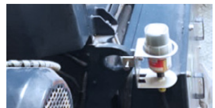
Rilubrificazione automatica dei cuscinetti del generatore
