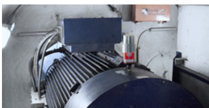
Rilubrificazione automatica dei cuscinetti del generatore
