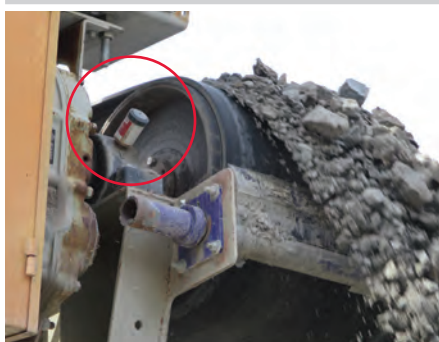
Lubrificazione del cuscinetto di un impianto a nastro trasportatore
