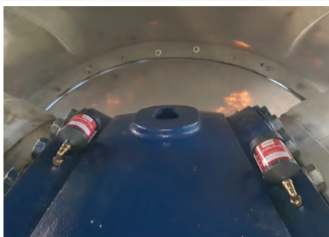
Lubrificazione del cuscinetto delle pale
