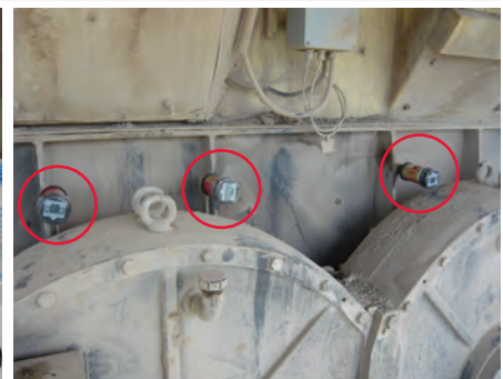
Lubrificazione di un impianto a nastro trasportatore
