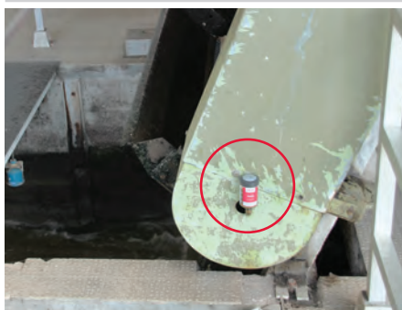
Lubrificazione dei supporti di cuscinetti nel caso di grigliatura grossolana
