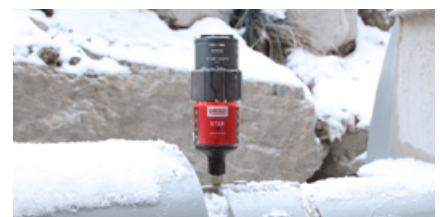
Lager- und Dichtungsschmierung einer Lüfteranlage
