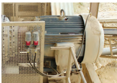
Ramię montażowe zawieszane na kracie ochronnej
