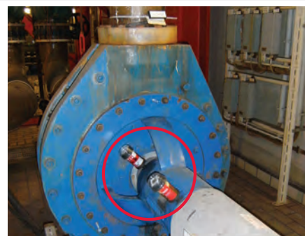
Smarowanie wałów napędowych pompy
