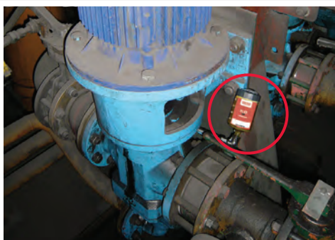
Smarowanie pompy paliwowej w procesie rafinowania
