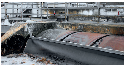
Lagerschmierung am Lüfter des Belebungsbeckens
