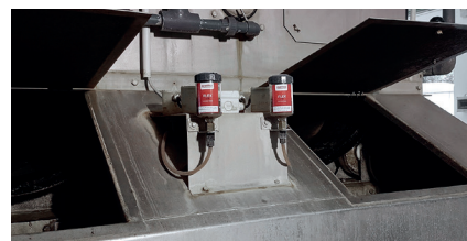
Lagerschmierung an der Überschussschlammwindung
