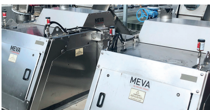
Schmierung von Siebzahnrollen
