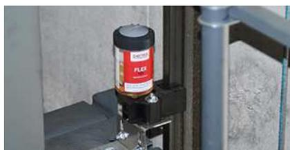
Schmierung der Führungsschienen an der Fahrgastkabine
