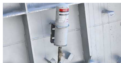
Lubrification d'un dispositif de ventilation
