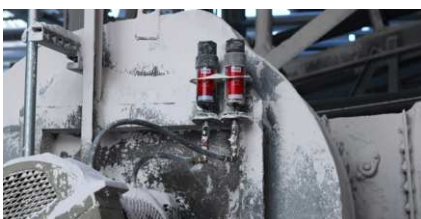
Lubrification d'un dispositif de ventilation
