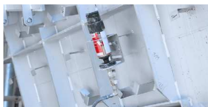
Lubrification d'un dispositif de ventilation
