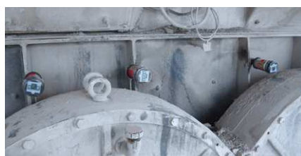
Lubrification d'un broyeur brut
