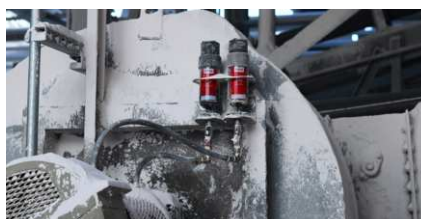
Lubricación del cojinete de un ventilador
