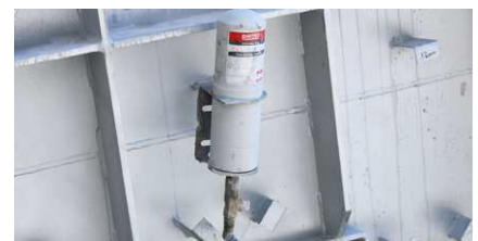
Lubricación del cojinete de un ventilador
