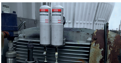
Schmierung von Elektromotoren
