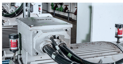
Schmierung von Elektromotoren
