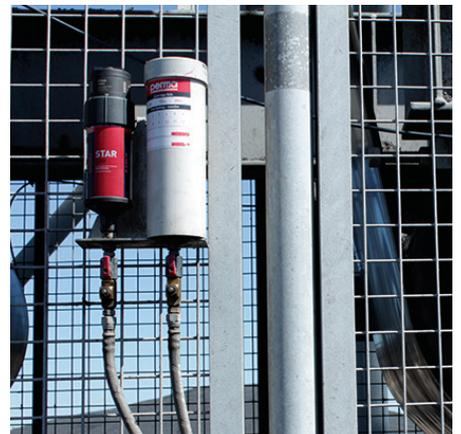
**Stratégie 3** – Lubrification automatique d'un équipement qui nécessiterait autrement des autorisations pour des travaux en hauteur ou dans des endroits confinés.
