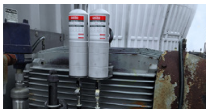
Schmierung von Elektromotoren
