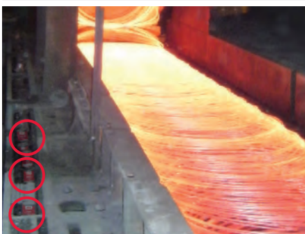
Schmierung von Antriebsketten (Schraubendrahtförderer)
