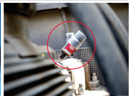
Lagerschmierung einer Lüfteranlage
