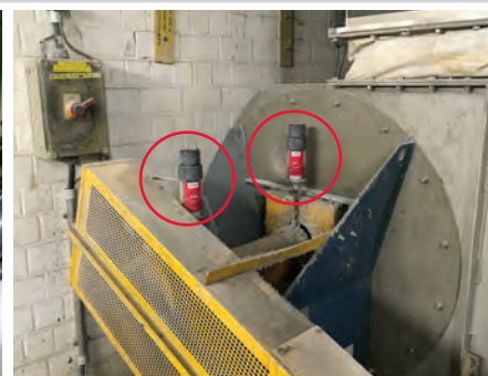
Promazávání ložisek větracího zařízení
