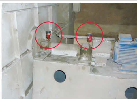
Promazávání stojanových ložisek hřídele ventilátoru
