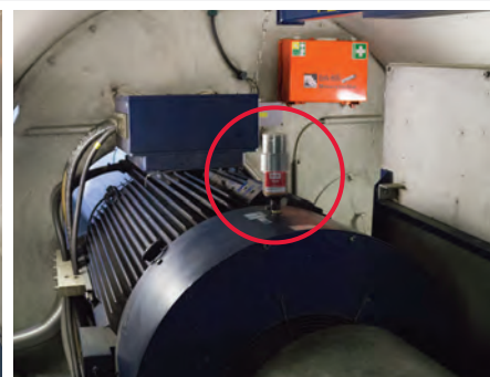
Automatické domazávání ložiska generátoru
