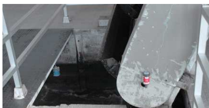
Lubrificazione dei rulli di guida delle catene
