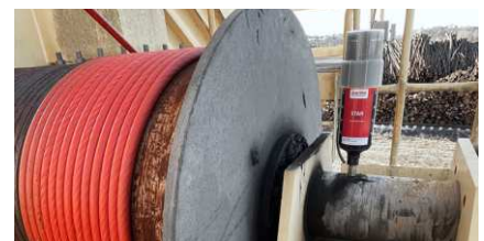
Lubrificazione dei cuscinetti delle pulegge delle gru
