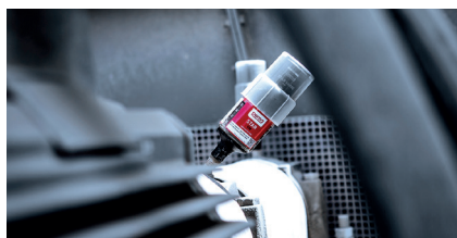
Lagerschmierung einer Lüfteranlage
