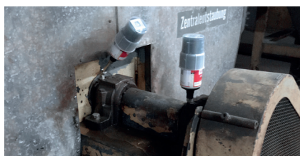
Lagerschmierung einer Lüfteranlage
