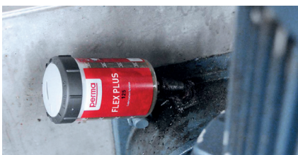
Lagerschmierung einer Pumpe
