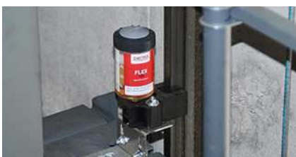
Lubrification des rails de guidage sur la cabine
