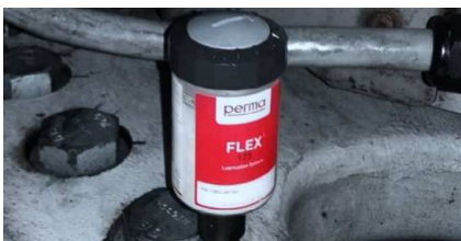
Lubrification de l'engrenage des pales
