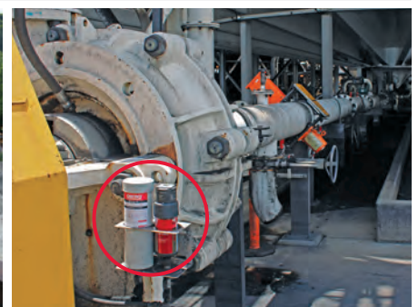
Lubricación de cojinetes / Lubricación de juntas de una bomba
