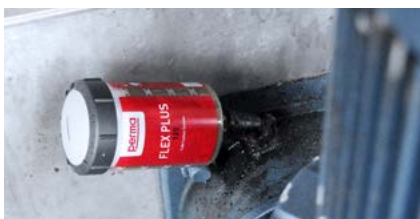
Lagerschmierung einer Pumpe
