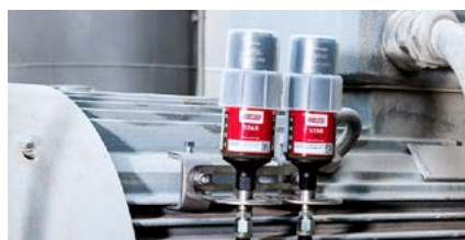
Lagerschmierung von Elektromotoren
