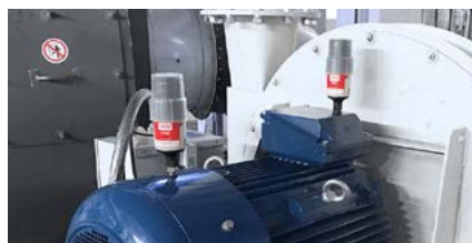
Lagerschmierung von Elektromotoren
