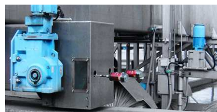
Lubrification du palier de roue sur le racleur circulaire
