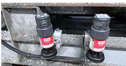
Lubrification d'un moteur électrique sur le séchoir
