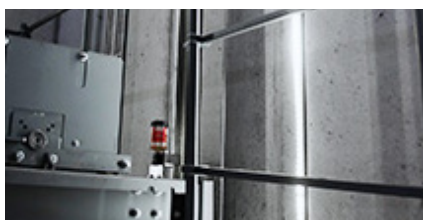
Schmierung der Führungsschienen an den Gegengewichten
