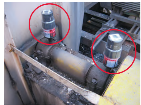
Smering van een ventilatoraslager
