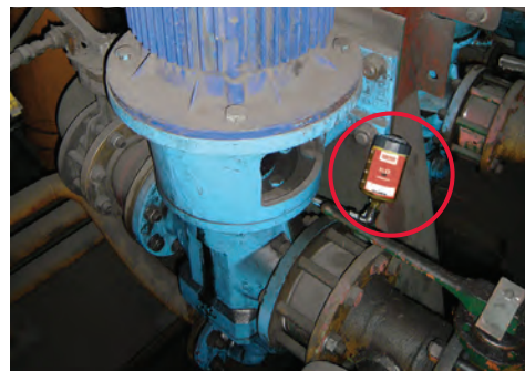
Smring van een brandstofpomp in het raffinageproces
