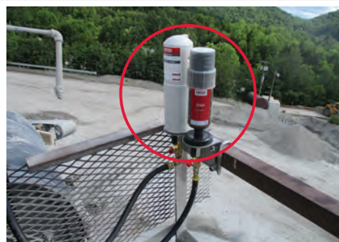
Lagerhuissmering van een transportband
