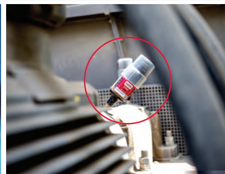
Lagersmering van een ventilator
