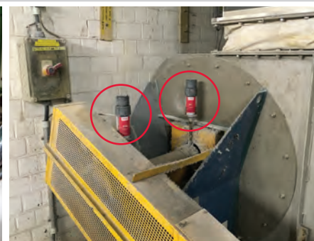
Lagersmering van een ventilator
