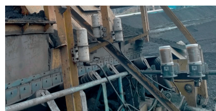
Schmierung an einem Schaufelradbagger
