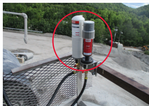
コンベヤーのピローブロックベアリングへの給油
