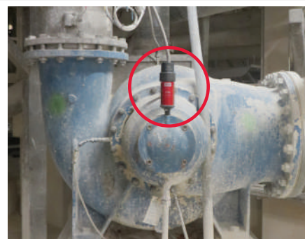
ポンプのベアリングへの給油
