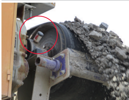
コンベヤーのピローブロックベアリングへの給油
