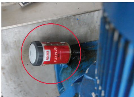
ポンプのベアリングへの給油
