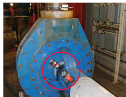
ポンプの駆動軸への給油
